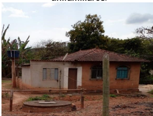
Figura 7.7 – Domicílios de residências unifamiliares.
