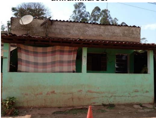
Figura 7.6 – Domicílios de residências unifamiliares.
