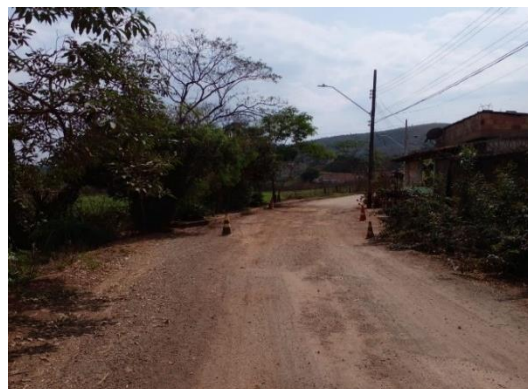
Figura 7.13 – Via não pavimentada.
